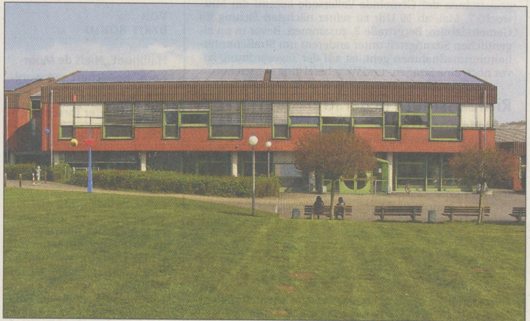
Die Photovoltaikanlage auf dem Dach der BBS wurde auf eine Leistung von 42 Kilowattstunden erweitert und soll 30.000 Kilogramm Kohlendioxid pro Jahr einsparen. Foto: Bosse
