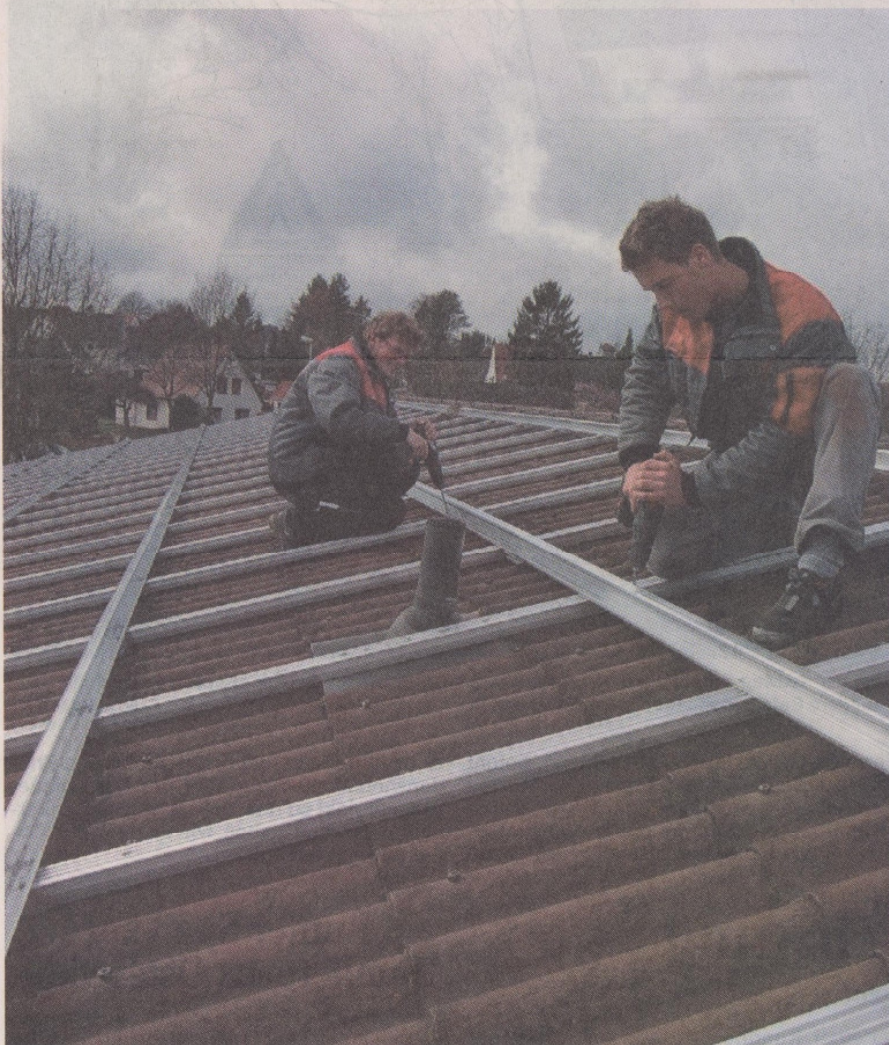
Mitarbeiter der Firma Osmer-Solartechnik aus Grasberg montieren das Trägergerüst für eine Photovoltaik-Anlage auf einem der BBS-Dächer.
