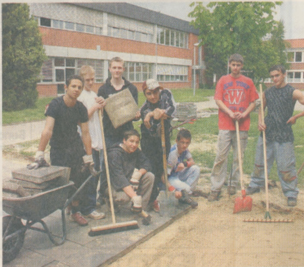
Die beiden BBS-Schüler Peter Brant und Jonas Bierwirth (rechts) mit den fleißigen Helfern der Heinrich-Horstmann-Schule an der Baustelle.
